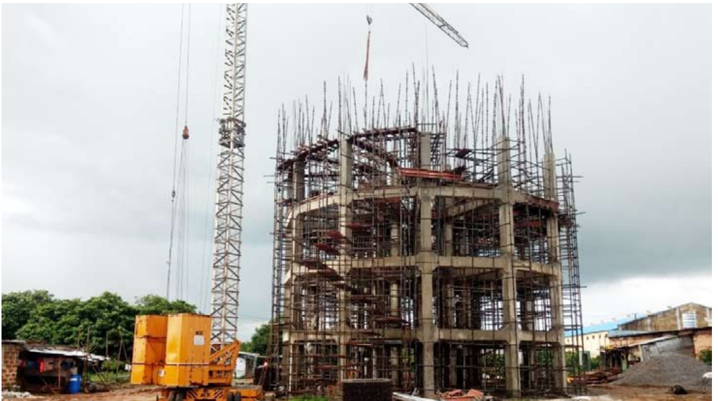
ELSR, Jatni (Construction Ongoing)
